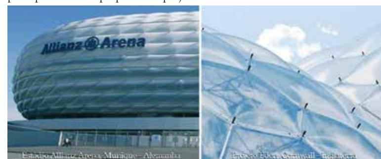
**ETFE** - Etileno tetrafluoretileno. É um polímero transparente que pode substituir o vidro. Comparados, o ETFE é 99% mais leve e 70% mais barato nos custos de instalação. Resiste 400 vezes seu próprio peso e pode ser esticado três vezes seu comprimento sem perder sua elasticidade, é auto limpante e tem uma durabilidade de 50 anos.
